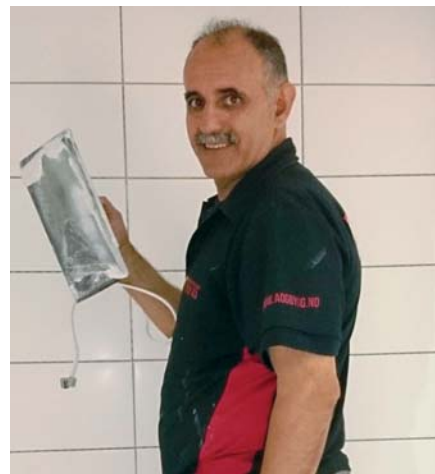
Cemal Barcin sjekker at fugingen er som den skal være.
