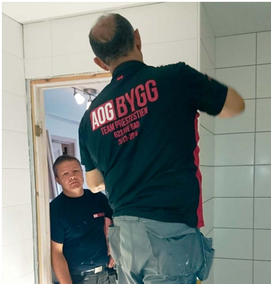
Rosen Malinov Koynarev (t.v.) og Cemal Barcin totalrenoverer et bad på Sørås.
