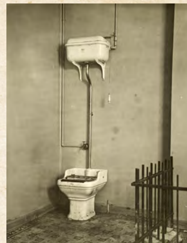
Vannklosett fotografert i 1915. Arkivet etter Vann- og kloakkvesenet, Bergen Byarkiv.
