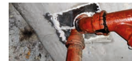
Tetting rundt avløpsrør for å hindre rotteinvasjon.
