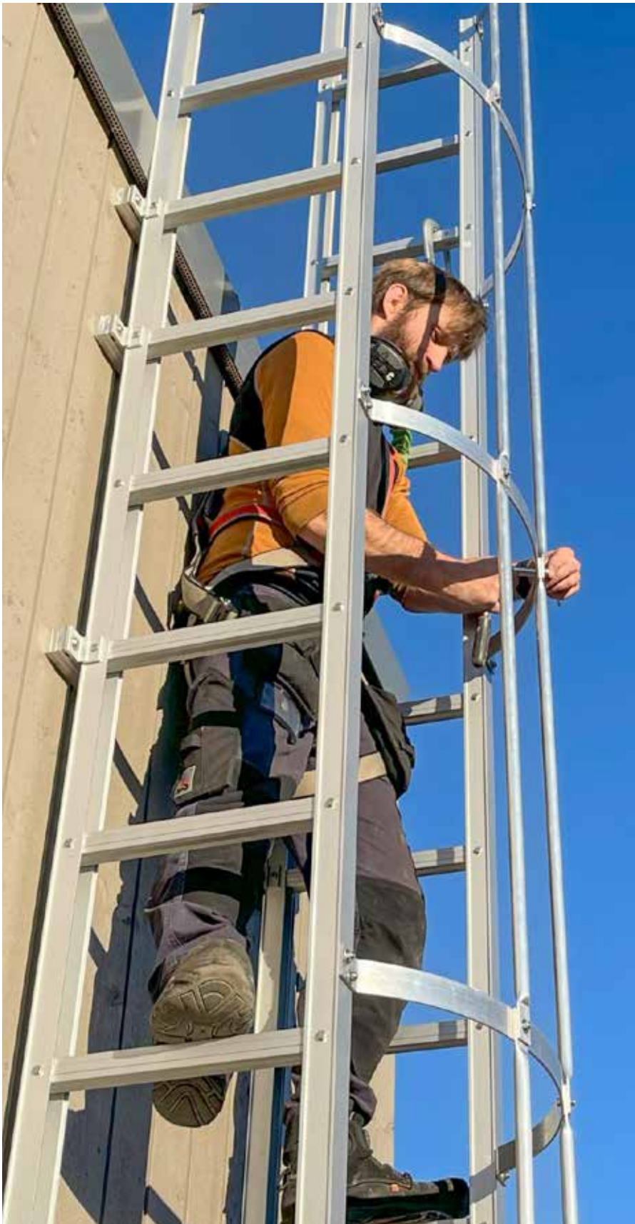
Espen Visnes monterer stige med utfellbar ryggbøyle. Dette er ingen jobb for de med høydeskrekk
