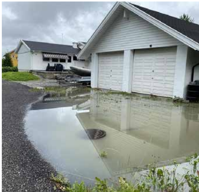
Oversvømmelser som følge av mer flom og ekstremnedbør stiller strengere krav til nye bygg.
