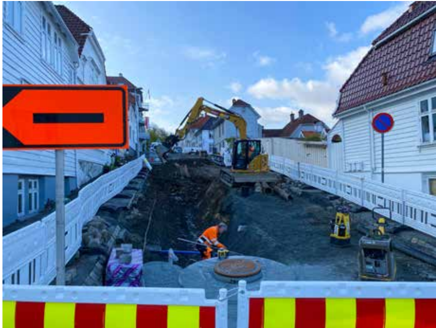
Arbeid på kommunal ledning i Henrik Wergelands gate
