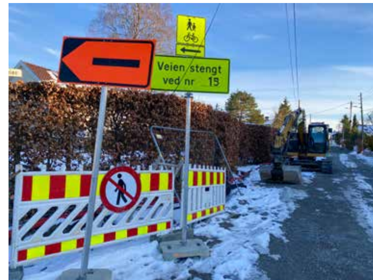
Veiarbeid og omkjøring i forbindelse med fornying av ledningsnett
