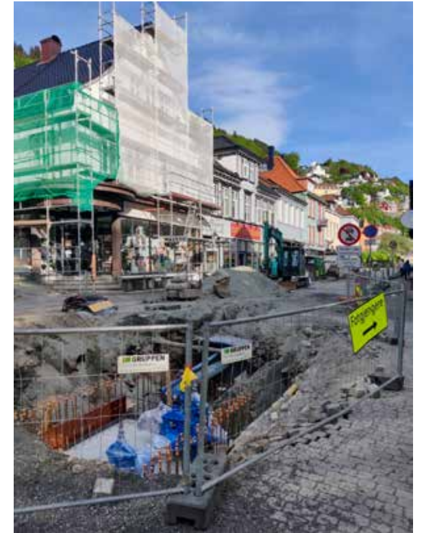
Fornyelsen av gamle vann- og avløpsrør i Bergen tar tid. Stengte gater går ut over næringslivet i de gatene som er berørt. Her fra Øvregaten.
