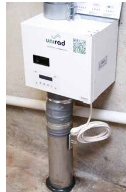
Her er radonbrønnen ferdig montert.
