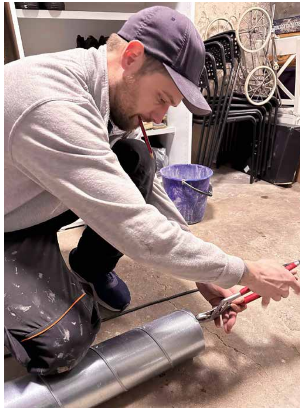
Installeringen av en radonbrønn tar alt fra fire timer til en dag.
