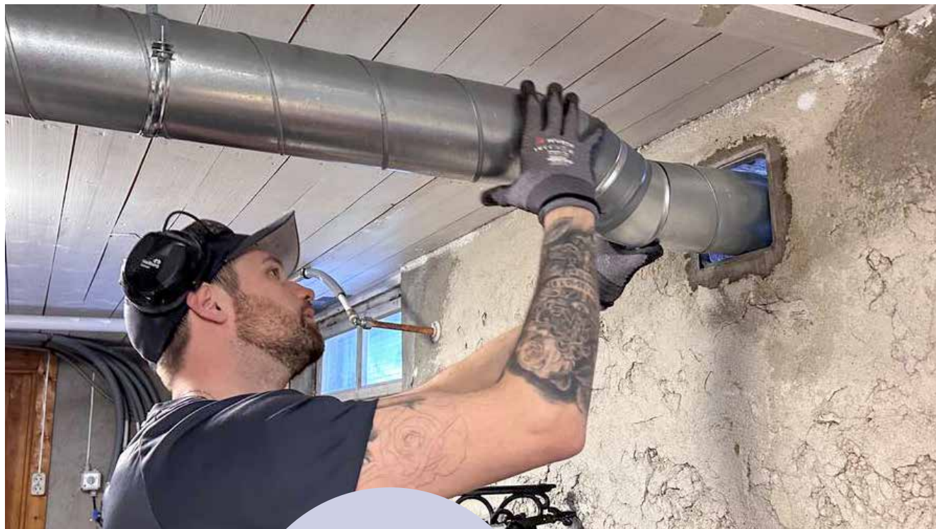
Dimensjonen på rørene er avgjørende. Unirad bruker dimensjoner på minst 125 mm.
