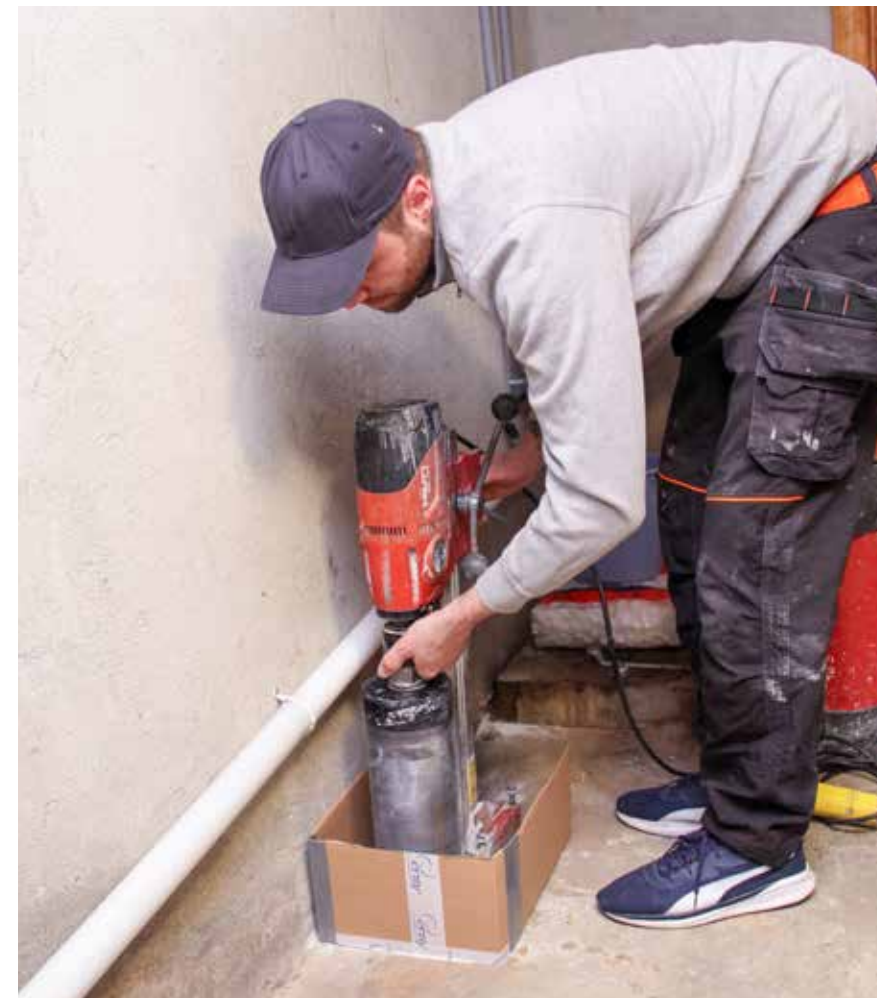
Her bores hull gjennom sålen i gulvet, hvor røret/brønnen plasseres og festes.
