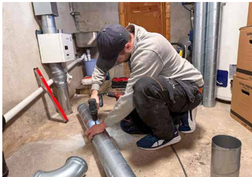
Installering av radonbrønn er et effektivt tiltak mot radon. (Foto: Helene Aarnes).
